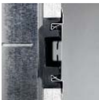
Double plaque de plâtre : dépasse de 3 mm
