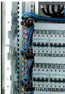
▲ **Sistema barre 250 A verticale laterale** installato sul lato sinistro delle strutture
