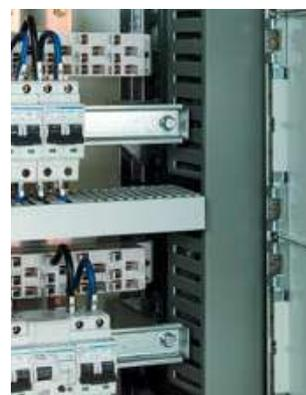
▲ **Fissaggio delle canaline orizzontali e verticali con supporto ad innesto**
